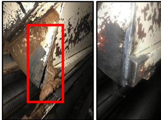
*Figura 6.4.1 Antes y después de filtración de tolva/compuerta del Refinador 1*
