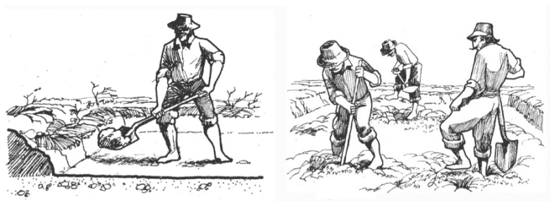
Figura N°4: Ilustración del oficio y trabajo en tierra. Fuente: Pineda, 2014.
