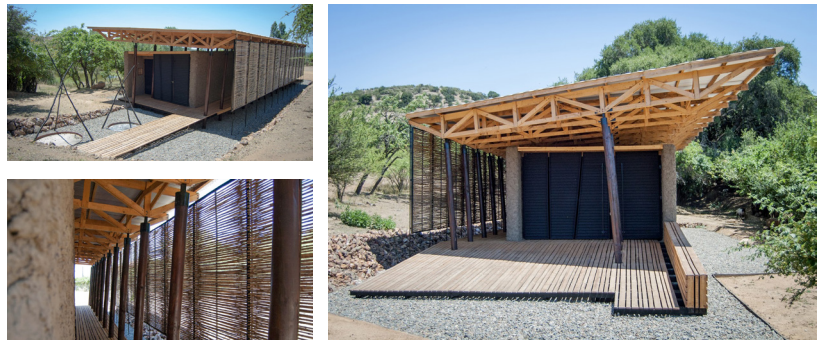
Figura N°43: Fotografías del Pabellón Vitivinícola. Fuente: Patricio Merino, 2012.
