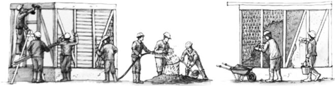
Figura N°3: Ilustración del proceso de utilización de la tierra como material de relleno Fuente: Hernández, 2016.
