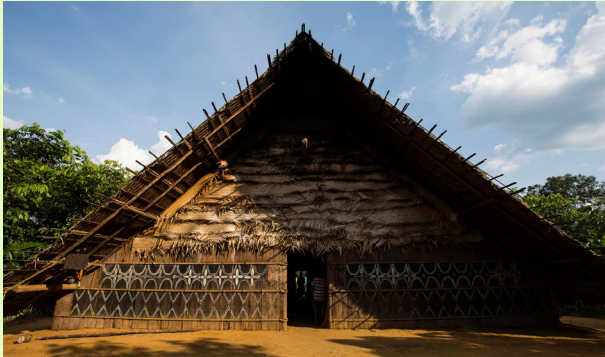
Maloca / Vivienda Tradicional del Amazonas
