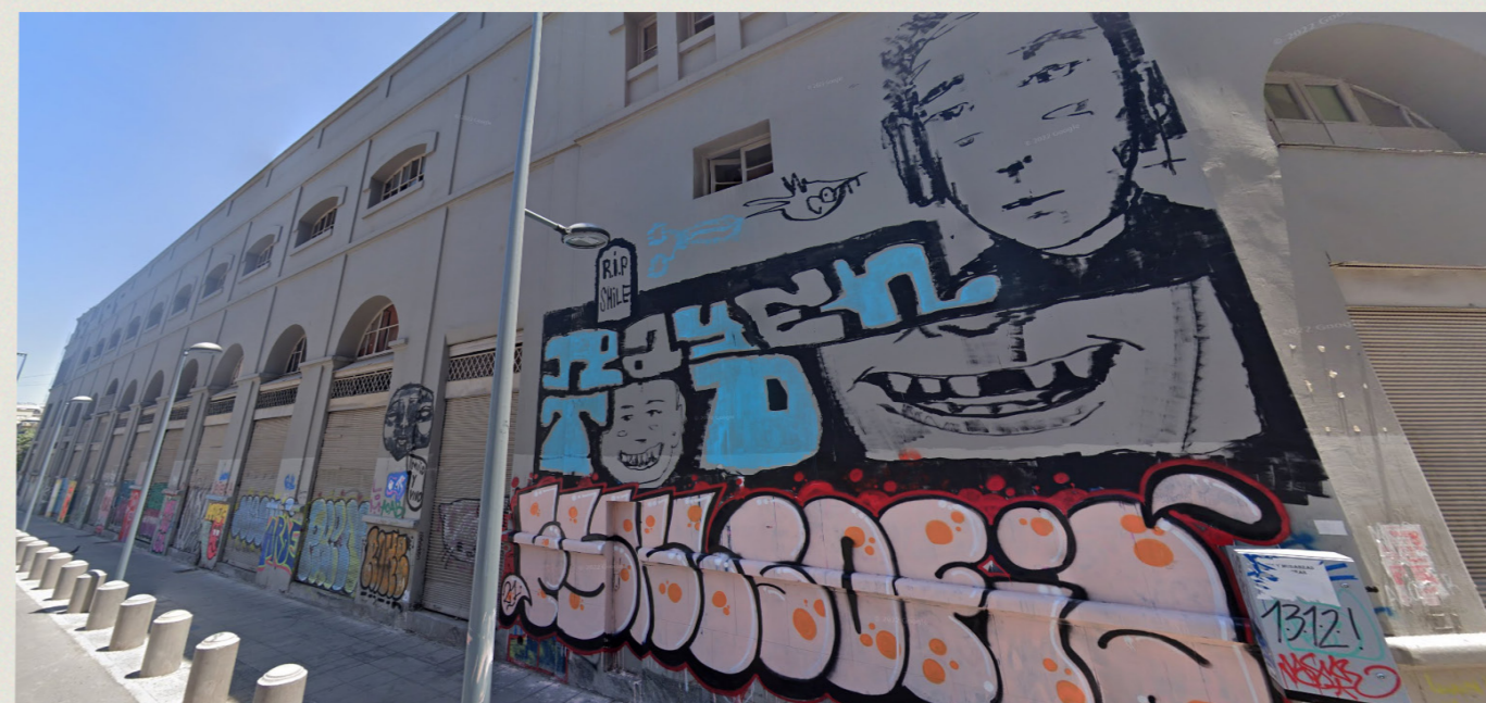
(37) Estado actual frente sur. Fuente: Elaboración propia en base a Google Street View.
