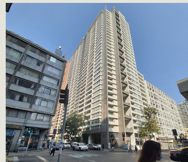
(6) Edificio protección mutua en la actualidad, Fuente: Elaboración propia.
