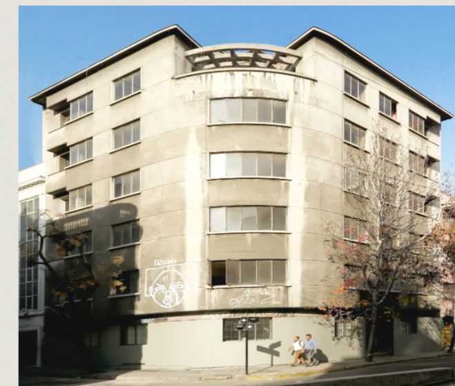
(12) Edificio Carmen 36, Fuente: Galio.cl
