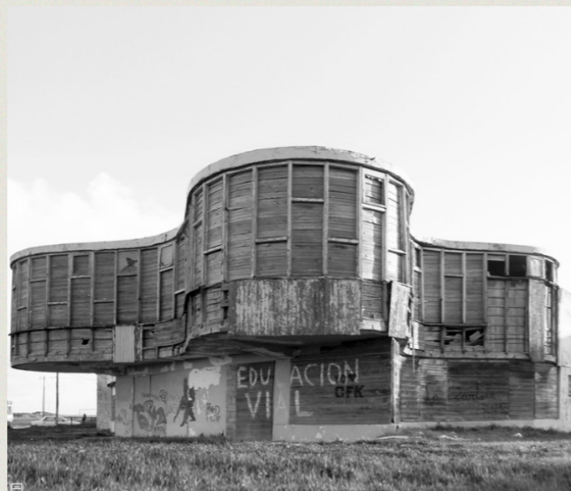
(1) Parador Ariston, Fuente: Plataforma arquitectura.cl
