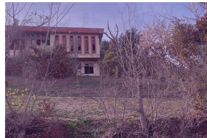
Imagen 27: Vista al pabellón 7 Fuente: Elaboración propia
