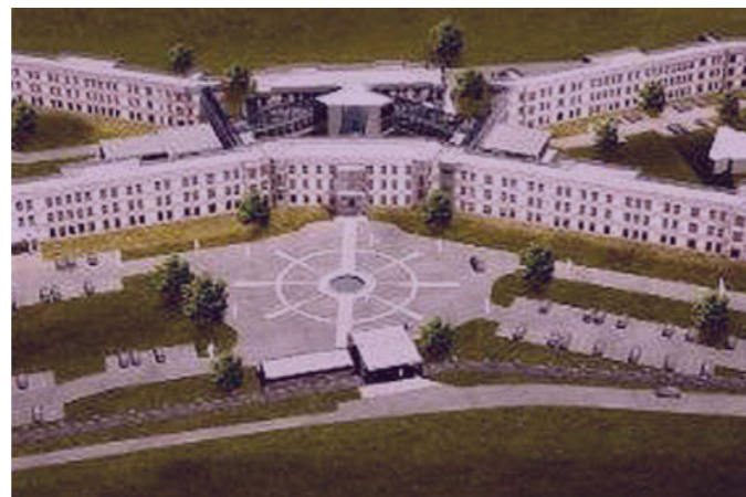
Imagen 24: Vista general del Hospital Fuente: monrabal.net
