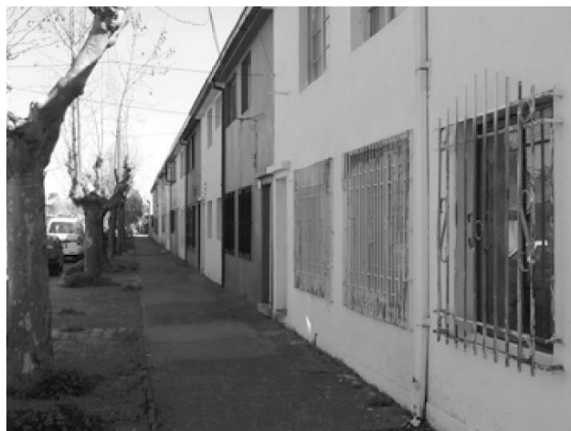
Fachada continua de calle Rosas. Fuente: Rodrigo Vera Manríquez.
