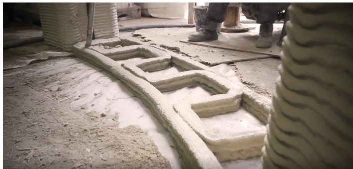
Figura 2: Paso del cordón de extrusión en House 05. Fuente: Foto entregada por la oficina del proyecto.
