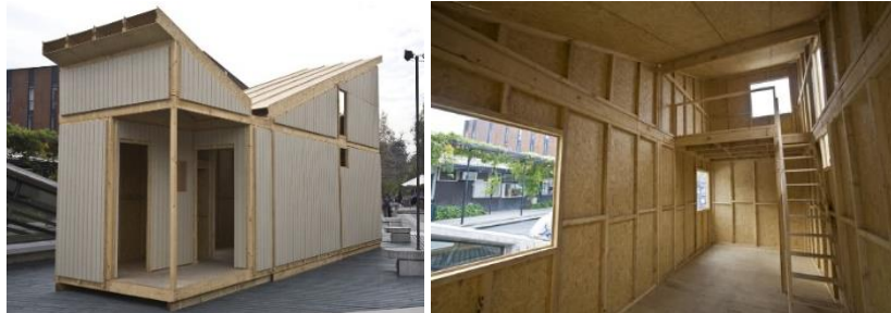
Izq. Figura 6 Vivienda de emergencia definitiva. Fuente: Omar Faúndes (2013)
