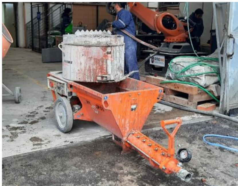
Imagen 23. Bomba hormigón. Fuente: Elaboración propia.
