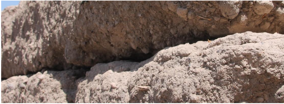
Figura 16: Elaboración propia. Sept, 2022. Detalle material del Tapial. Fotografía.
