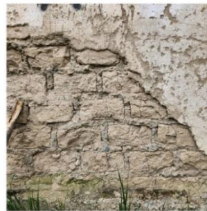
Figura 6: Muro de adobe
