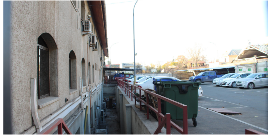
Figura 31 Patio inglés en borde oriente del edificio de Servicios Público Colección del autor
