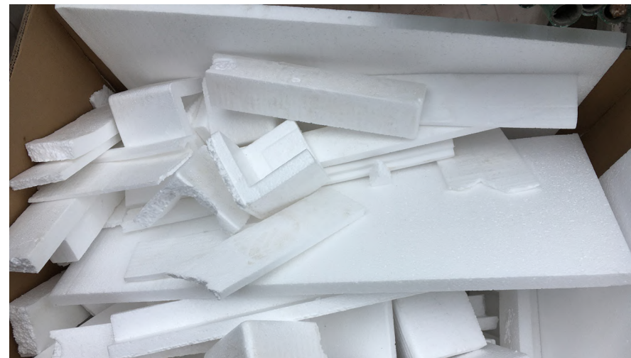
Figura 20: EPS recopilado en obra Fuente: Elaboración propia, 2021
