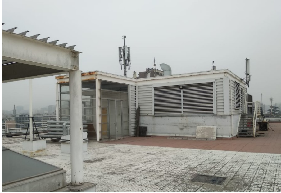
Figura 4.1.1: Azotea Torre Norte, Beauchef 851.
