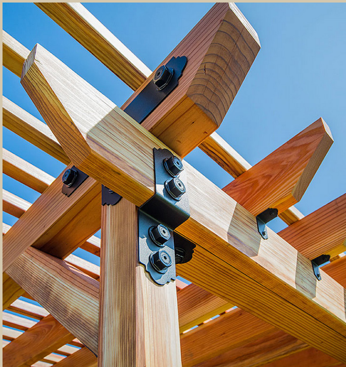
Fig. 77 : Uniones en acero / Fuente: Plataformaarquitectura.cl
