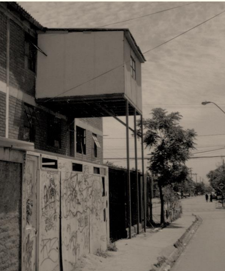
Figura 14: Ampliación irregular en vivienda de tipología "block". Fuente: Portada "LOS CON TECHO: un desafío para la política de vivienda social."
