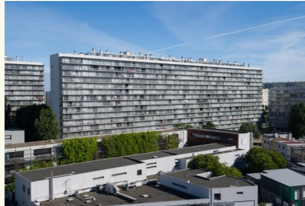
GRAND PARC BORDEAUX, BURDEOS, FRANCIA LACATON & VASSAL - FRÉDÉRIC DRUOT - CHRISTOPHE HUTIN ARCHITECTURE
