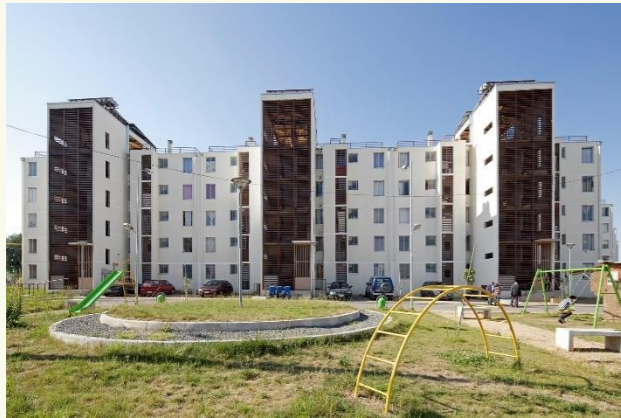
CONJUNTO HABITACIONAL SOCIAL MONSEÑOR LARRAÍN, TALCA, CHILE BIOURBAN ARQUITECTOS
