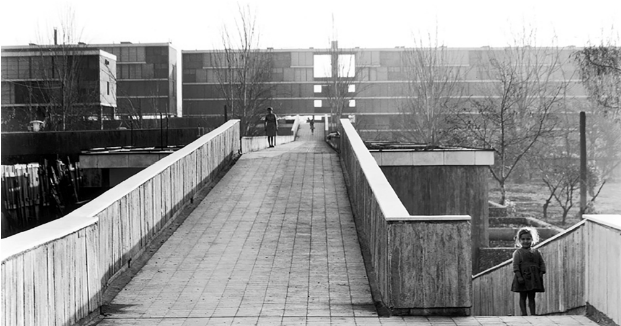
Figura 5: Pasarelas que conectan las viviendas con las áreas verdes [Fotografía] Hidden architecture, s.f.
