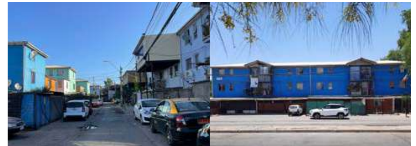
Imágenes 42 y 43: conjunto habitacional Tucapel Jiménez Fuente: Elaboración propia.
