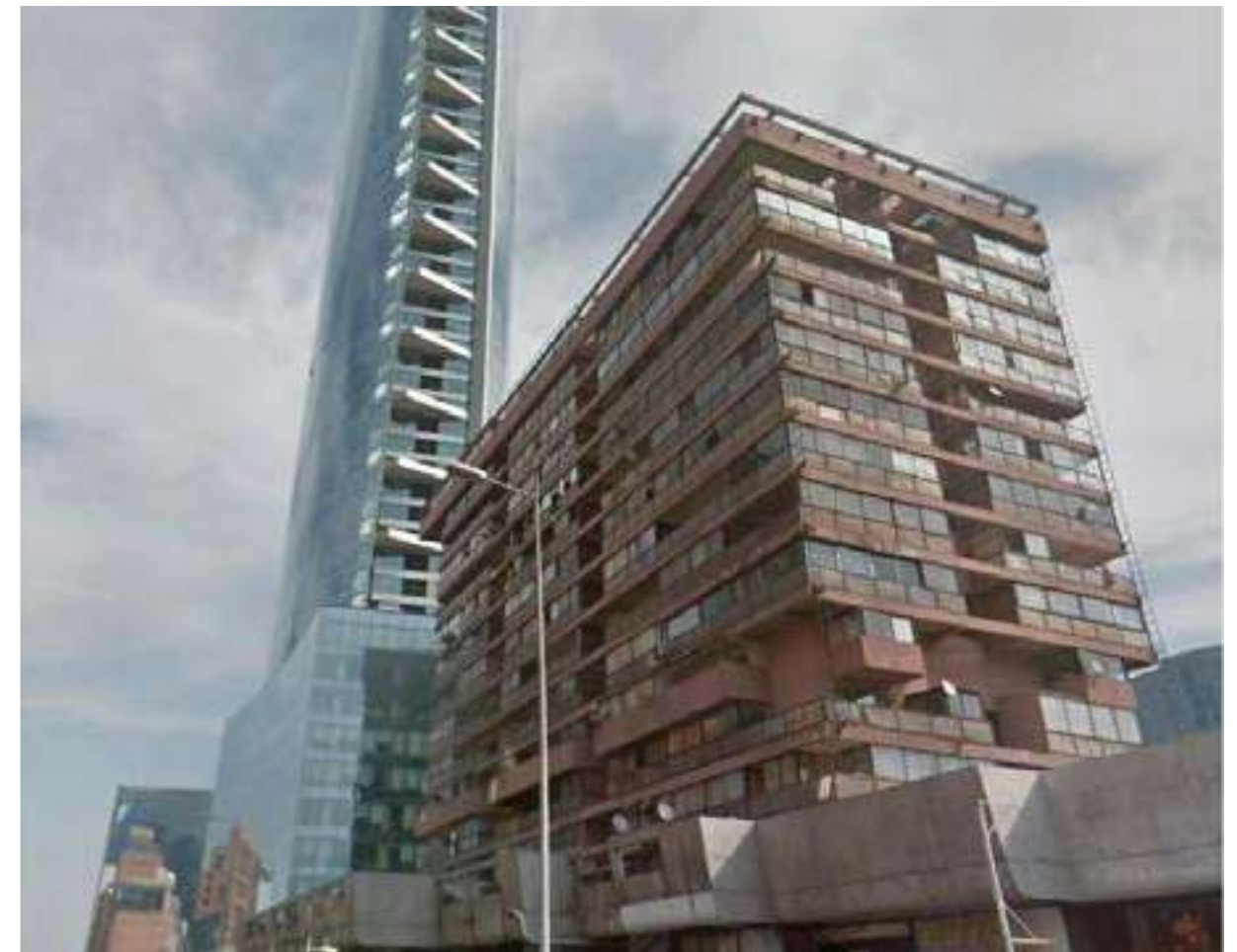
Imagen 15: Edificio “La portada de Vitacura”. Fuente: Google maps
