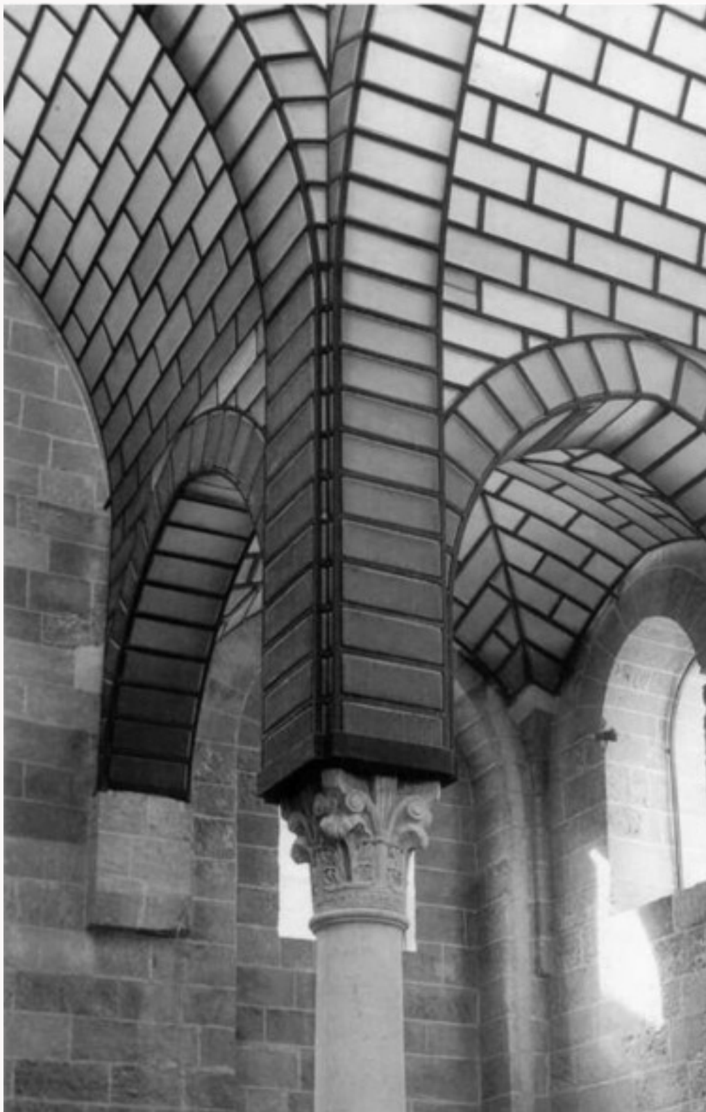
Figura 5: La Iglesia de S. Nicolò Regale en Mazara del Vallo, Trapani (Sicilia), F. Minissi, 1960–66: Sistema abovedado en paneles de plexiglás translúcido, 1959.
