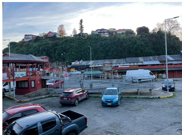
Fig. 28 Vista a rampa Fuente: Elaboración propia
