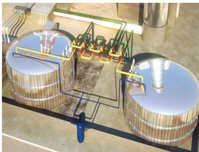
Figura 2.9: Sistema de almacenamiento de tanques de sales fundidas (Fuente: Crescent Dunes).
