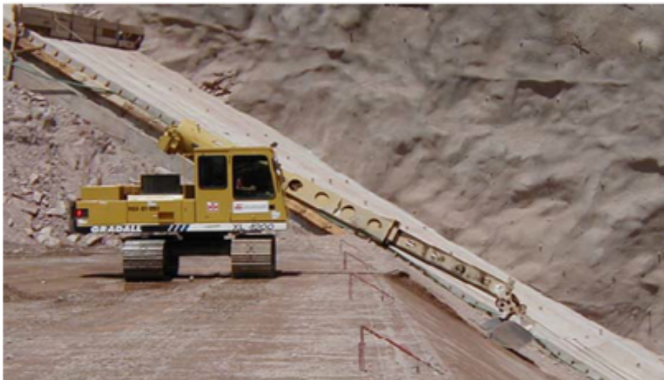
Figura 4.23: Perfilado talud; Fuente: Ing. de presas de Escollera.
