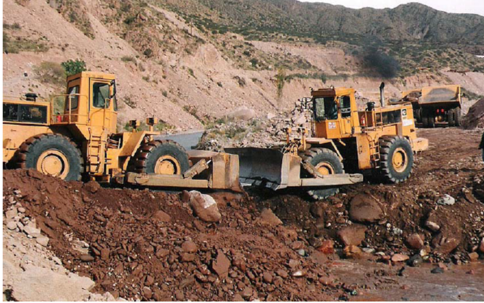
Figura 4.8: Cierre progresivo; Fuente Ing. Presas de Escollera.
