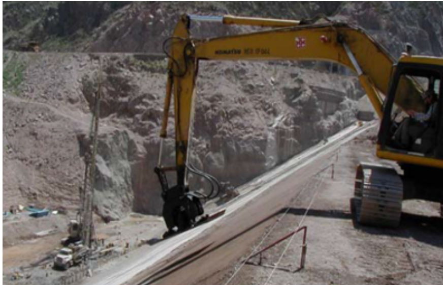
Figura 4.24: Compactación 2B con placa vibradora; Fuente: Ing. de presas de Escollera.
