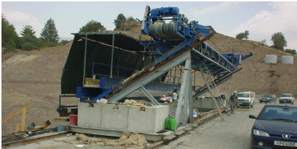
Figura 4.34: Estructura transferencia cimbra; Fuente: Comité Nacional Chileno De Presas.
