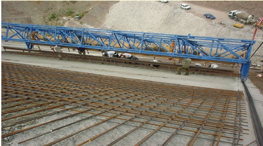
Figura 4.30: Estructura apoyo para armadura; Fuente: Comité Nacional Chileno De Presas.
