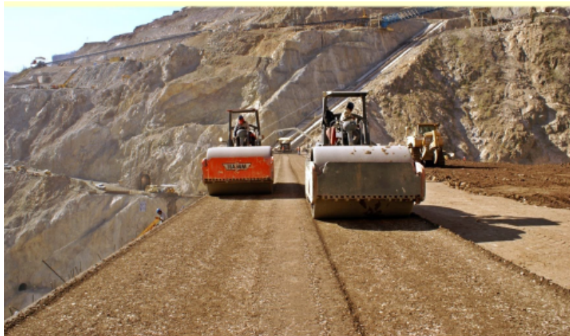
Figura 4.22: Compactación 2B. Fuente: Comité Nacional Chileno De Presas.
