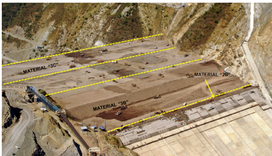
Figura 4.28: Trabajos de relleno en presa la Yesca, México. ; Fuente: Comité Nacional Chileno De Presas.
