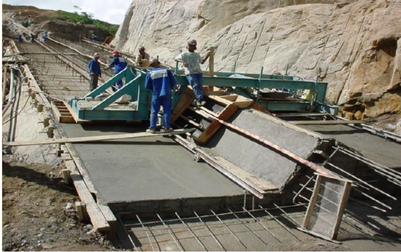
Figura 4.12: Moldaje plinto; Presa de Itapebi, Brasil.
