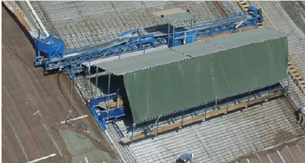
Figura 4.33: Moldaje deslizante para hormigonado; Fuente: Comité Nacional Chileno De Presas.
