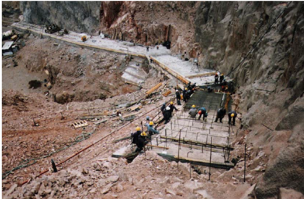
Figura 4.14: Construcción plinto en ladera Presa Potrerillos, Argentina; Fuente: Ing. de Presas de Escollera.
