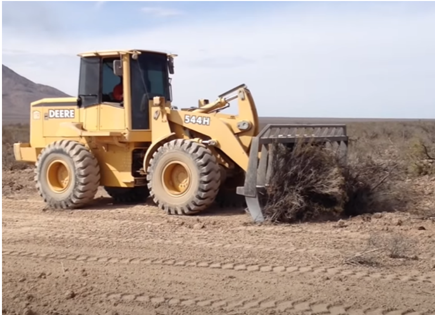
Figura 4.1: Limpieza de terreno con cargador frontal.
