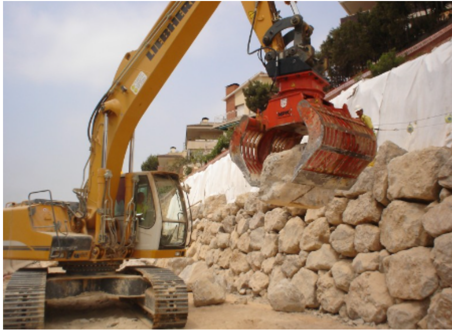
Figura 4.26: Pinzas de escollera y manipulación; Fuente: Catalogo ALEXIMPORT.
