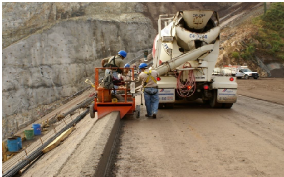
Figura 4.25: Colocación bordillo extruido; Fuente: Comité Nacional Chileno De Presas.
