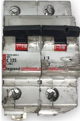
Figura B.15: Termomagnético Legrand C125
