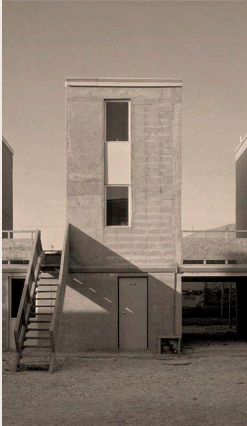
Figura 1 | Vivienda Incremental, Proyecto Quinta Monroy, ELEMENTAL. Vivienda social que se entrega completamente terminada y pensada como “la mitad” de una casa, construida para que sus habitantes puedan refaccionarla y ampliarla de forma que se adecue a sus necesidades y condiciones según su situación familiar y económica. Fuente: Plataforma Arquitectura
