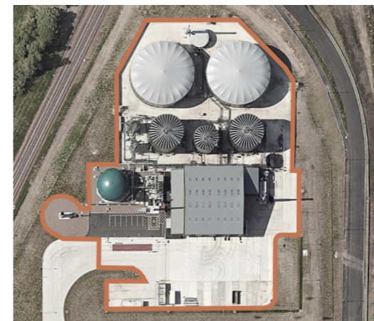
Millerhill Energy Center / Escocia Capacidad 35.000 toneladas al año Superficie planta: 10.500 m 2 Empresa Biogen Beneficios: generación eléctrica de 1,5 MW para 3500 viviendas
