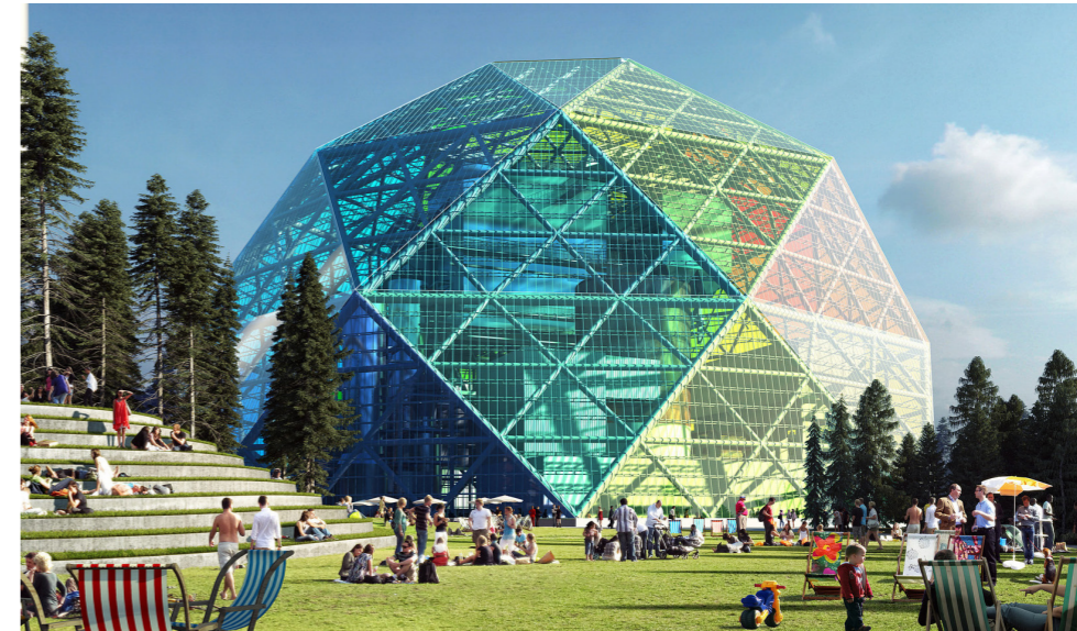
Upsala Power Plant Fuente: Plataforma Arquitectura
