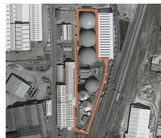
Teesside Green Energy Plant / Escocia Capacidad 120.000 toneladas al año Superficie planta: 12.000 m 2 Empresa Durata Energy Beneficios: generación eléctrica de 7,4 MW
