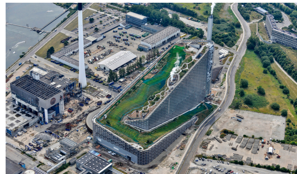
Copenhill Waste-to-energy Power Plant Fuente: Plataforma Arquitectura
