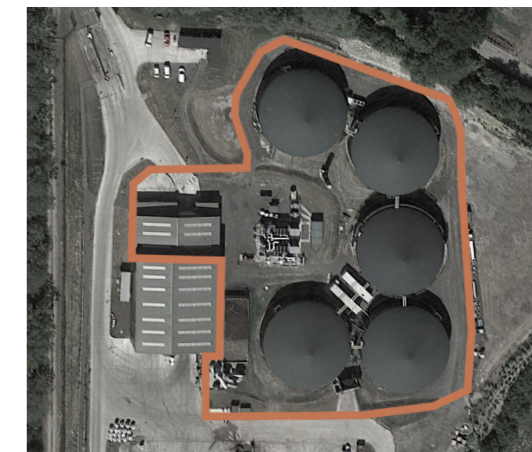
Severn Trent Green Power and Composting Facility / Inglaterra Capacidad 50.000 toneladas al año Superficie planta: 9.500 m 2 Empresa Severn Trent Green Power Beneficios: generación eléctrica de 2,4 MW
