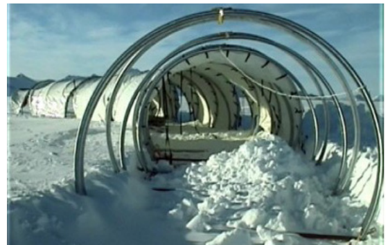
Estructura y armado Eptap - Etación Polar. Fuente: Presentaciones Fuerza Aérea Chilena facilitadas por el Comandante (BA) Fernando Machuca
