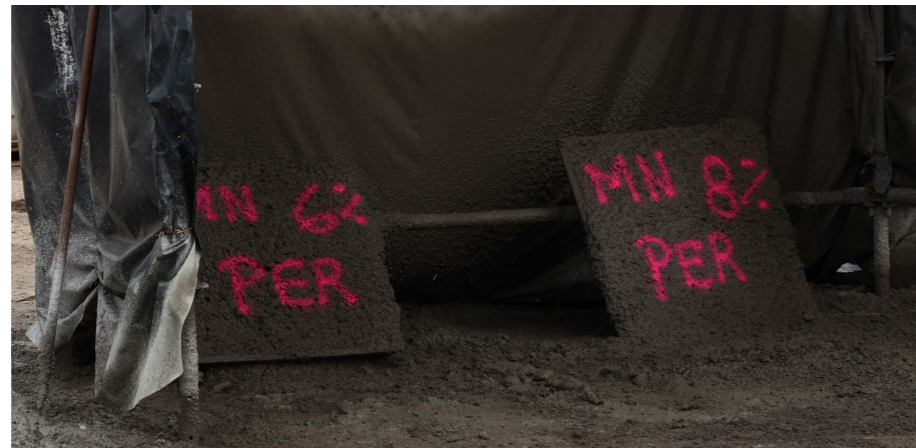
Figura 78: Cajones muestras de shotcrete. Foto a solicitud de la autora.
