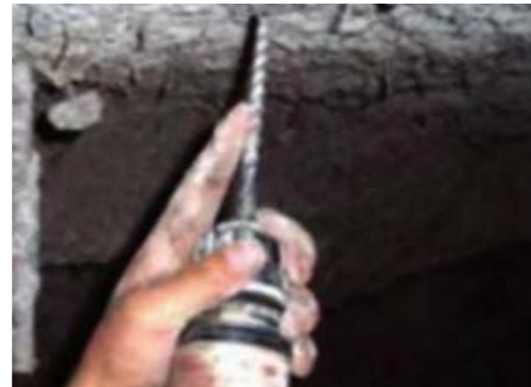
Figura 36: Control de espesor por perforación. (ICH, 2018, p.78)
