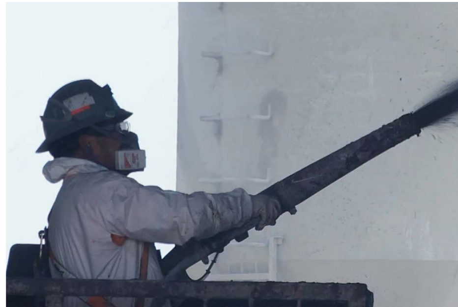
Figura 34: Pitonero proyectando shotcrete. Elaboración propia.
