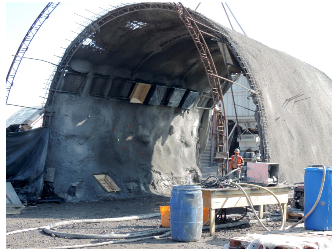
Figura 79: Túnel falso, lugar a realizar las pruebas de shotcrete. Elaboración propia.
