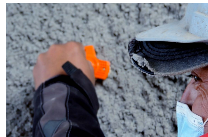
Figura 114: Colocación del prototipo en la pared túnel falso. Elaboración propia.
