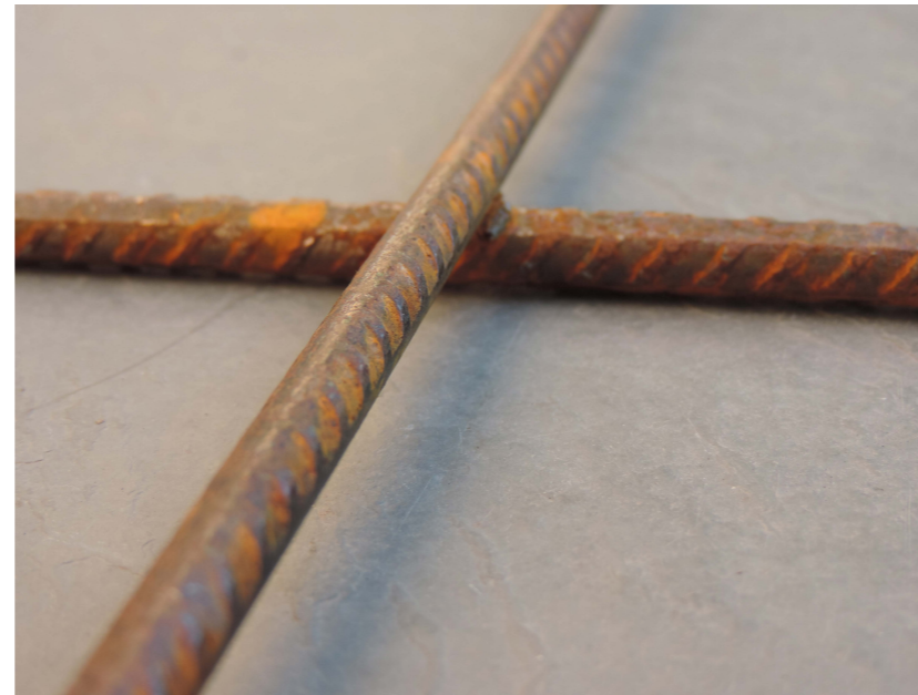
Figura 57: Unión de la malla electrosoldada. Elaboración propia.
