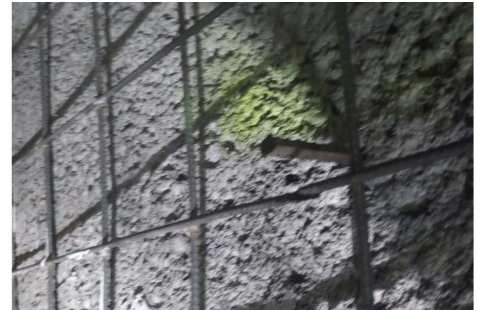
Figura 35: Uso de fierros para marcar espesor. Fotografía a solicitud de la autora.
