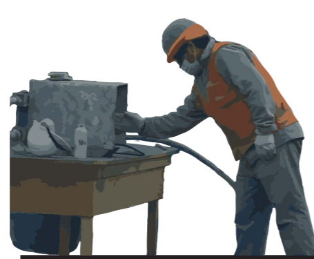
Operador de compresora y flujo de aditivo
