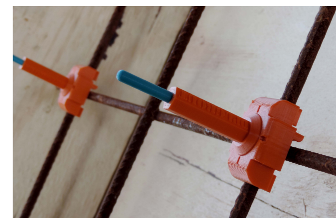
Figura 110: Prototipos instalados. Elaboración propia.
