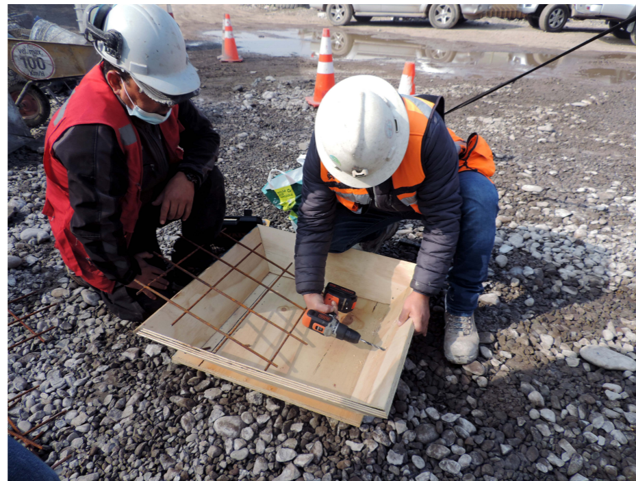
Figura 82: Preparación de cajón para shotcrete con malla Acma. Foto a solicitud de la autora.
