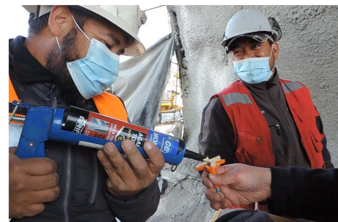
Figura 113: Colocación de pegamento. Elaboración propia.
