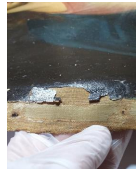
Figura 44, Desprendimiento de capas
