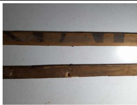
Figura 170, Madera de bastidor no adecuada
