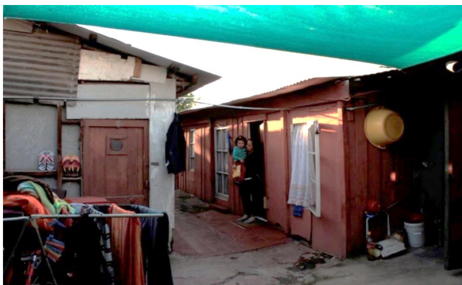
Figura 25: Allegamiento en una vivienda de San Joaquín
