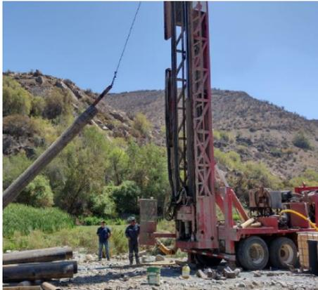
(a) Perforadora realizando entubación.
