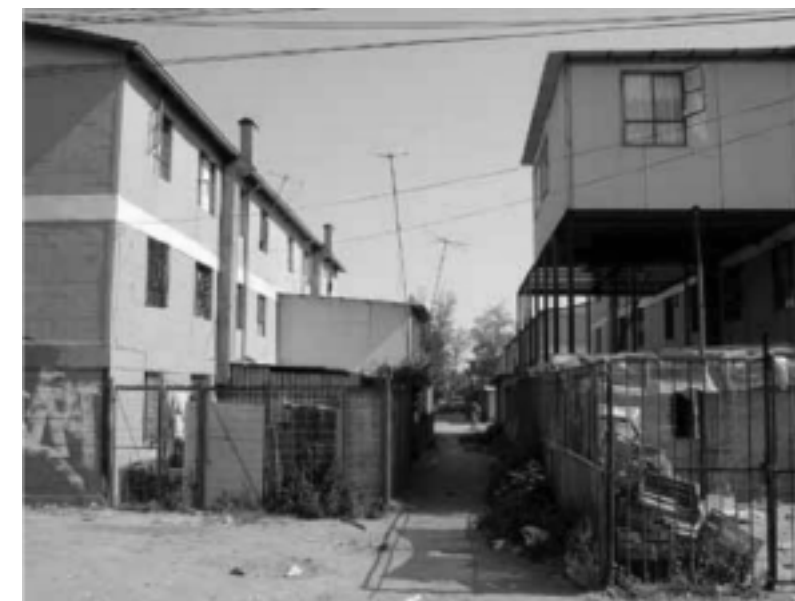
Ampliación Irregular en conjunto de vivienda social, via El Mercurio, 15/06
