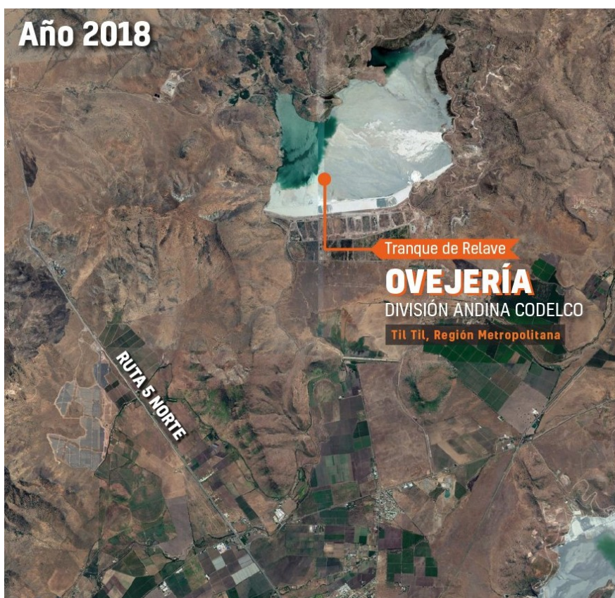
Figura 4.10: Vista satelital de Tranque de Relaves Ovejería (relaves.org).
