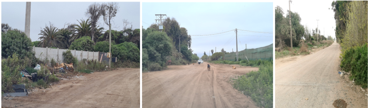
Figuras 37, 38 y 39 en vía 5 Rodillo
