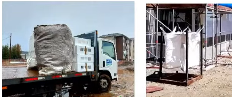
Figura 3.15: Retiro del poliestireno expandido de obra para su tratamiento de fabricación de pinturas de Poliestirec. Fuente: Exposición Encuentro Técnico "Gestión de residuos en obra".
