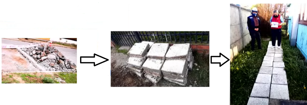
Figura 3.14: Reutilización de acera que se debía demoler para un proyecto en Punta Arenas. Fuente: Exposición Encuentro Técnico "Gestión de residuos en obra".
