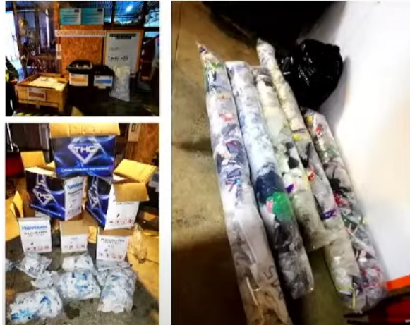
Figura 3.13: Cartón y plástico tipo film segregado y almacenado en bodega. Fuente: Exposición Encuentro Técnico "Gestión de residuos en obra".
