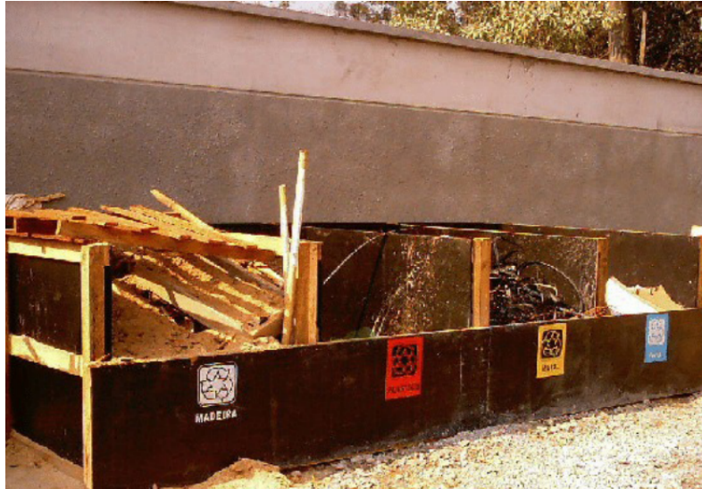
Figura 3.29: Ejemplo de clasificación de materiales en obra. Fuente: ( greenrec.cl , 2022)
