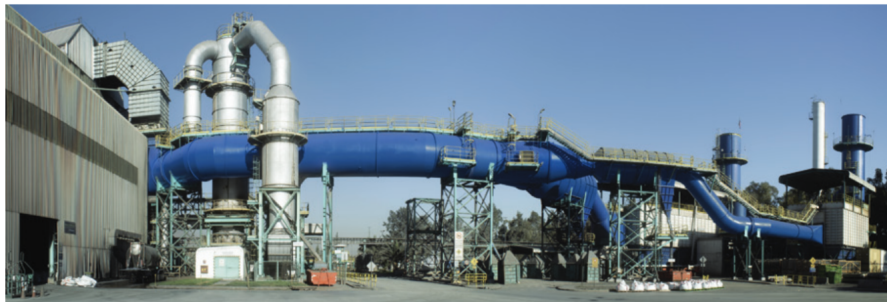
Figura 3.17: Planta de tratamiento de AZA ubicada en Colina. Fuente: ( Reporte de Sostenibilidad AZA 2021, 2021 )
