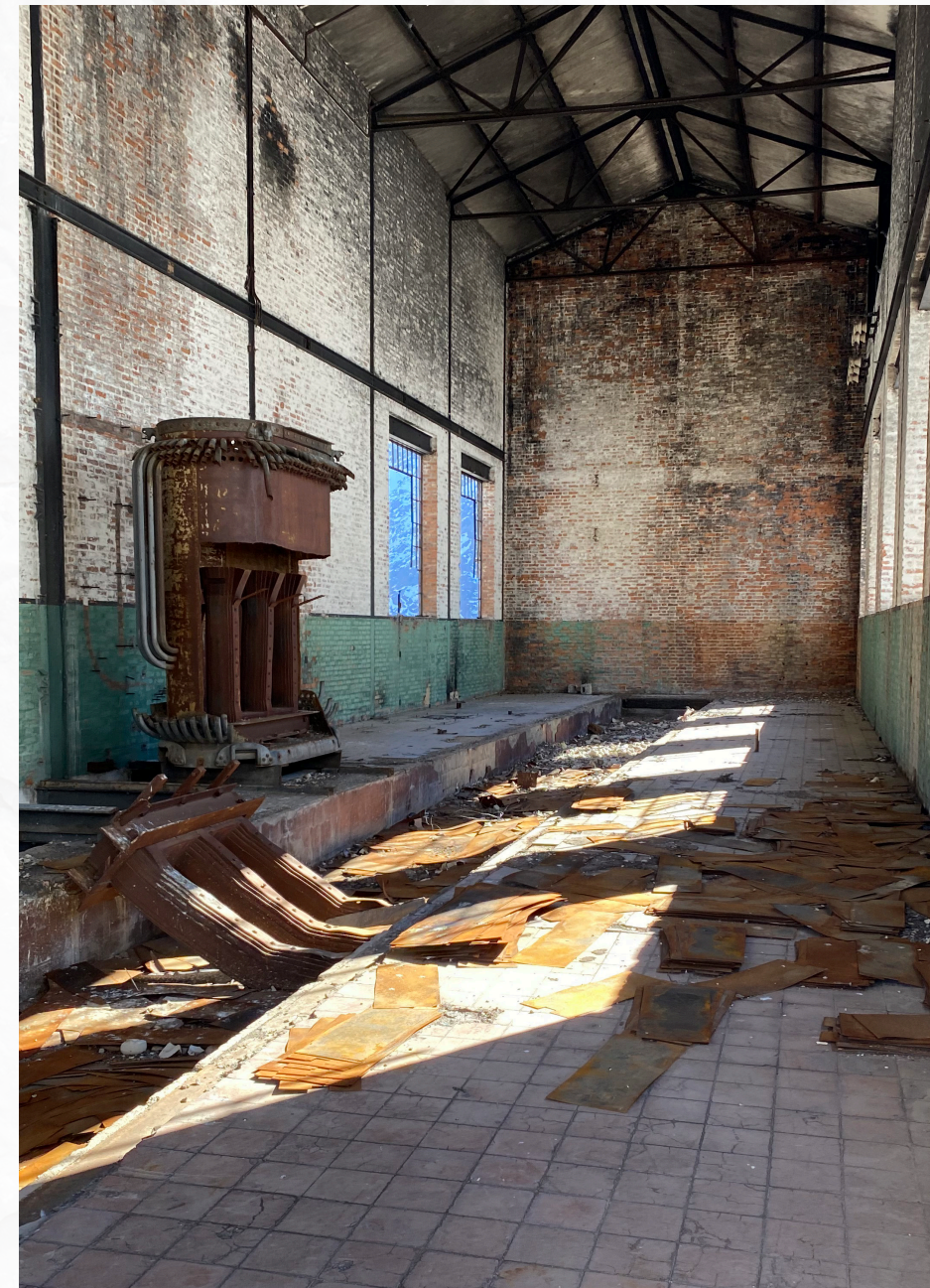
Figura 27. Interior del edificio de la Subestación. Fotografía de 2021.
