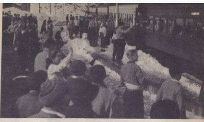
Partida en la ruta internacional del ferrocarril transandino por Juncal. En esta localidad se encuentran las lunetas canchales de espal, mudamente conocidas
