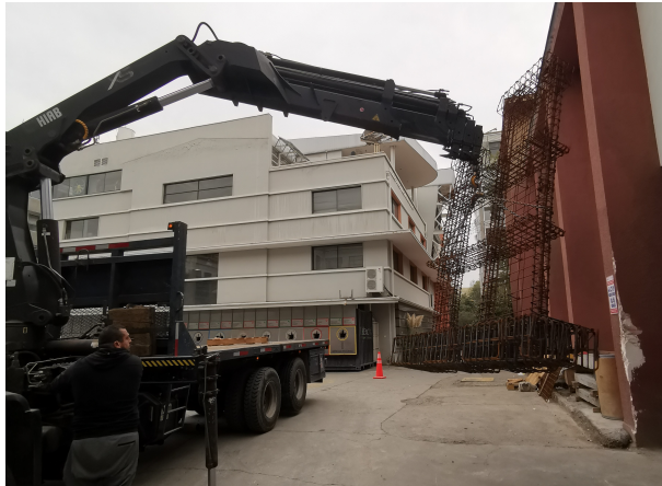
(a) Arribo de la Probeta a dependencias del Laboratorio de Estructuras, Idiem.
