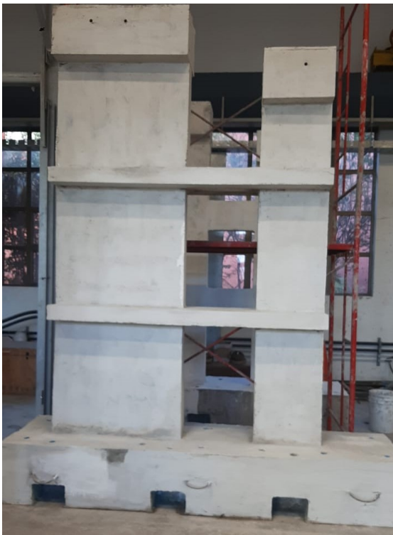
(a) Daño Registrado en el Pedestal
