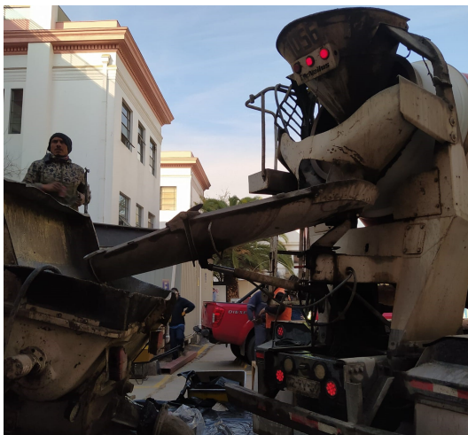
(a) Camión de Bombeo del Hormigón
