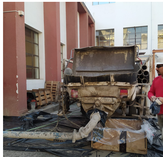
(b) Instalación de Tuberías de Bombeo
