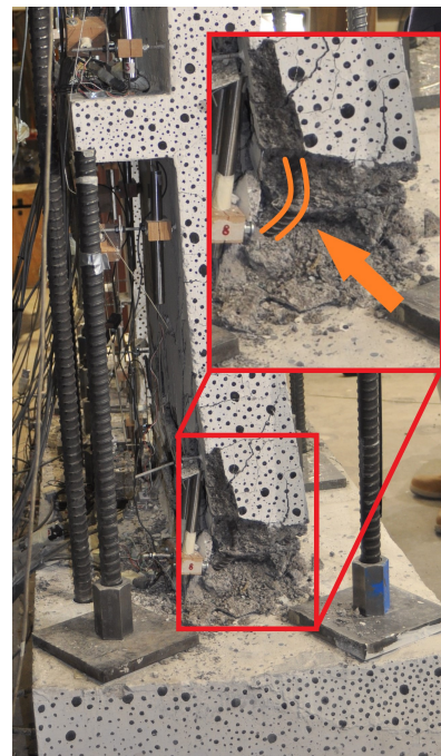
(d) -4 %-Segundo Ciclo. Se Observa Pandeo del Refuerzo
