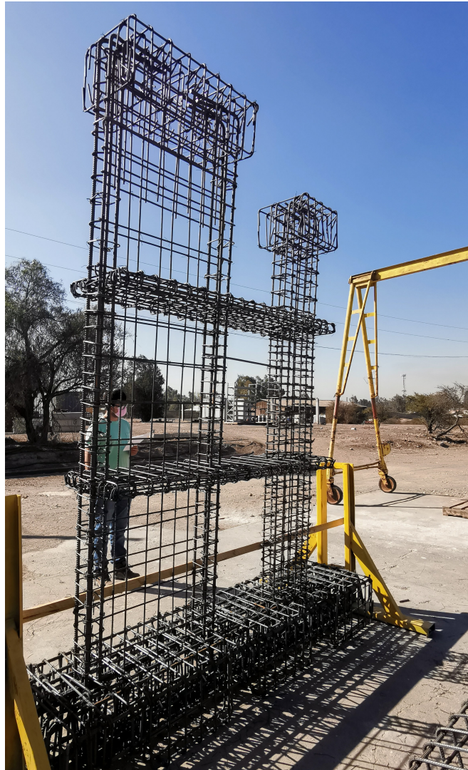
Figura 4.2: Armadura de la Probeta Finalizada
