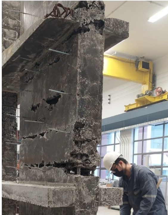
(c) Exposición de Armadura de Borde por Problemas de Hormigonado. Muro Grande
