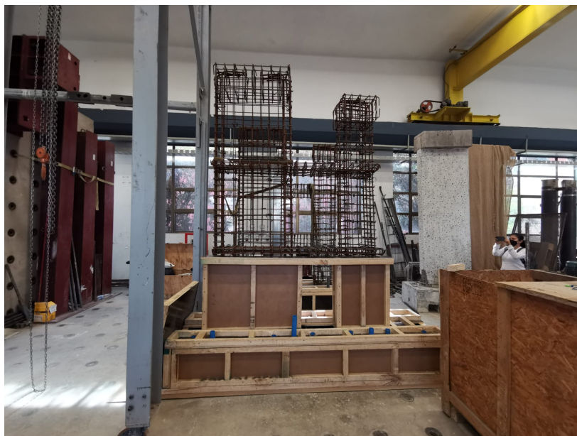
Figura 4.14: Construcción parcial del moldaje en el sitio de ensayo.
