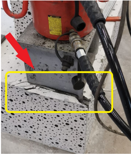
(a) Daños Sufridos por el Pedestal al Momento del Postensado (1)
