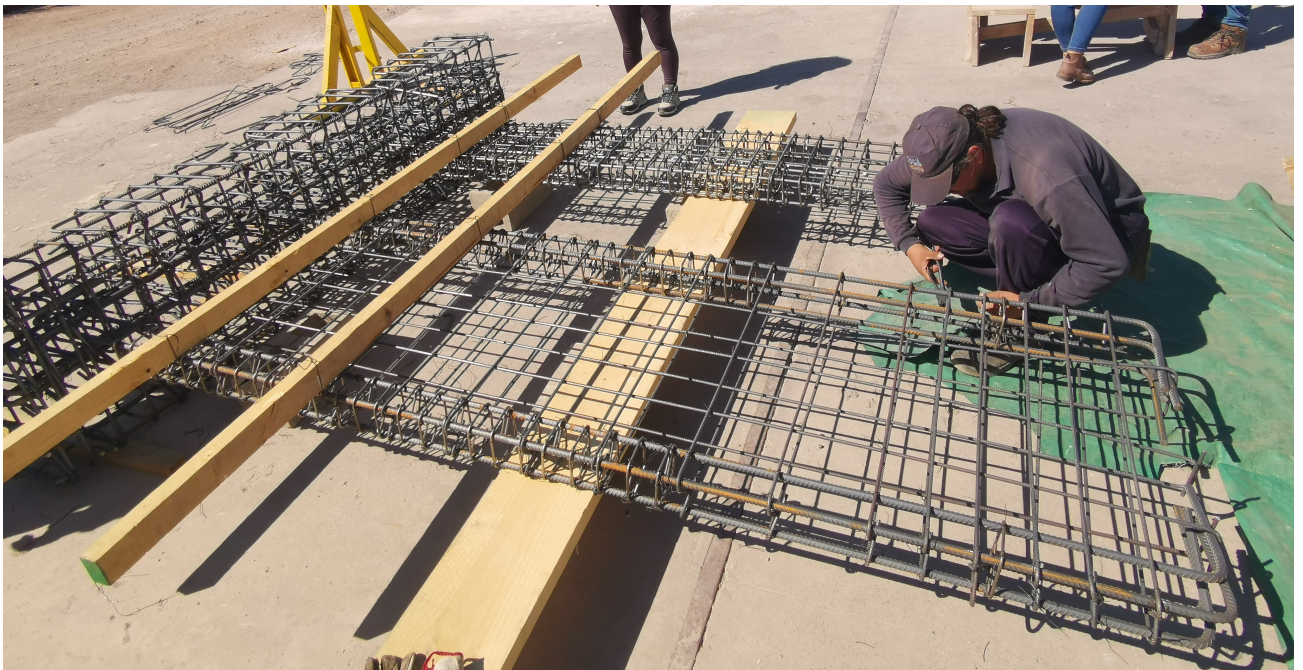
Figura 4.1: Proceso Inicial de Construcción de Armadura
