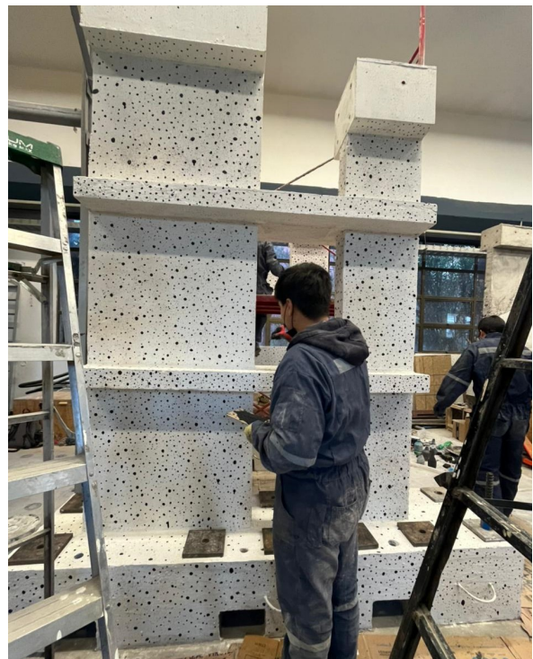
(b) Daño Registrado en el Pedestal
