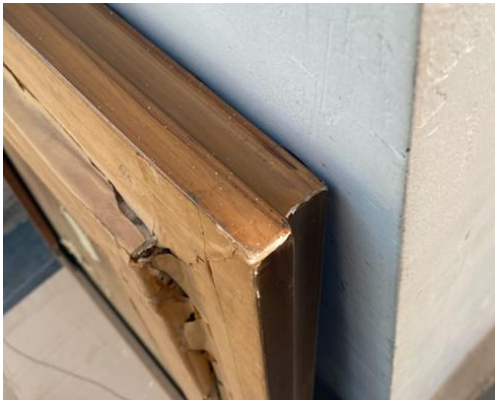
Ilustración 133: Presencia de papel kraft, que resguarda el calce entre el bastidor y marco.
