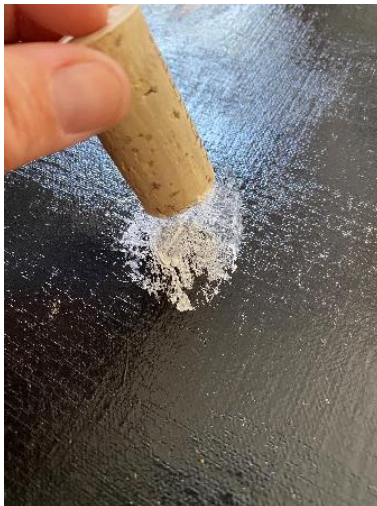
Ilustración 114: Técnica que utiliza un corcho para asegurar que el resane quede liso y a nivel.
