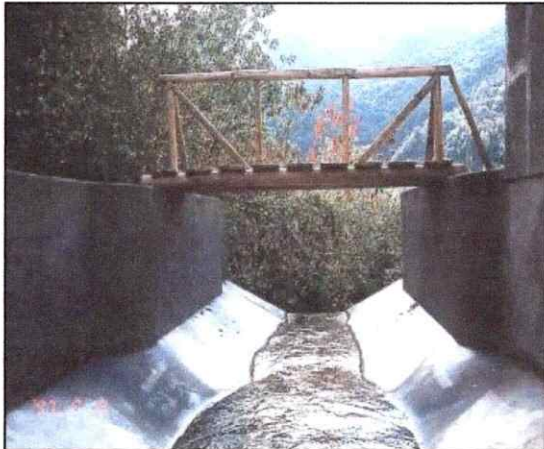
Figura 14. Aforo tipo flume en las microcuencas
