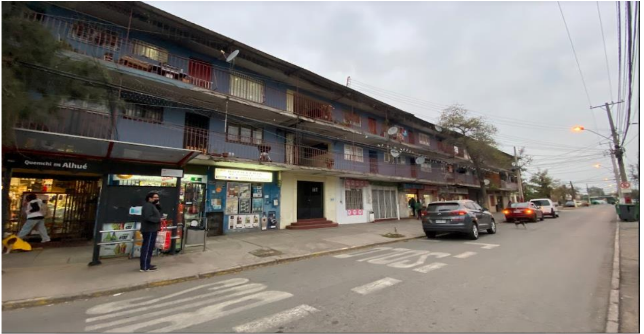
Ilustración 7 Edificio de tres pisos, dos pisos habitacionales, primera planta comercial
