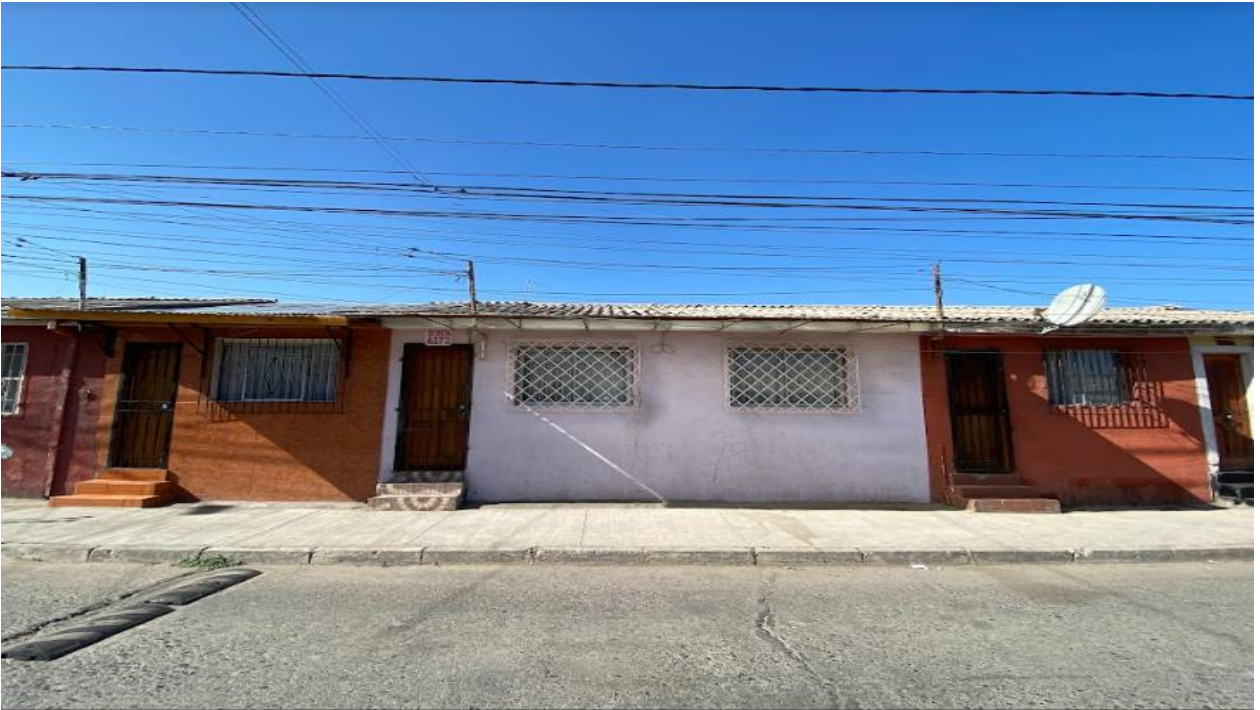
Ilustración 4 Fachada continua con salida a la calzada
