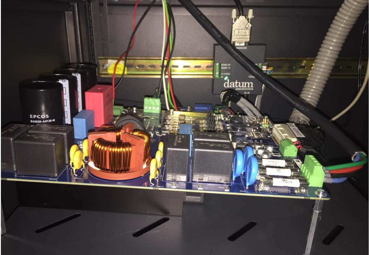
Figura 4.21: Montaje de la electrónica del sistema de control dentro del Rack .
