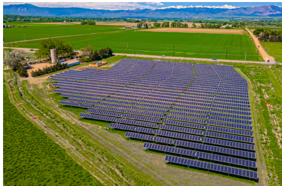
Figura 9.5.3: Proyecto agrivoltaico Jack's Solar Garden, Colorado [10].
