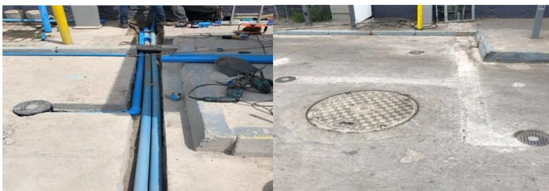
Figura 7: Instalación de cañerías y llenado de zanjas.
