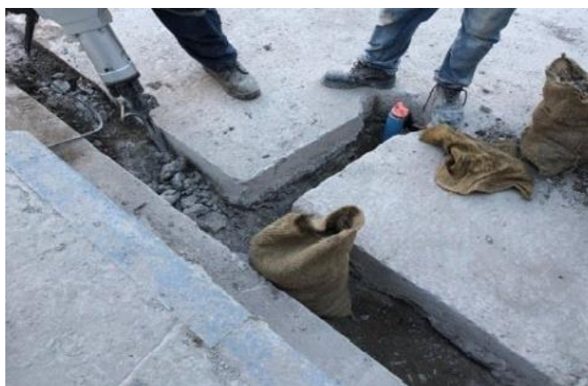
Figura 6: Proceso de construcción de zanjas.
