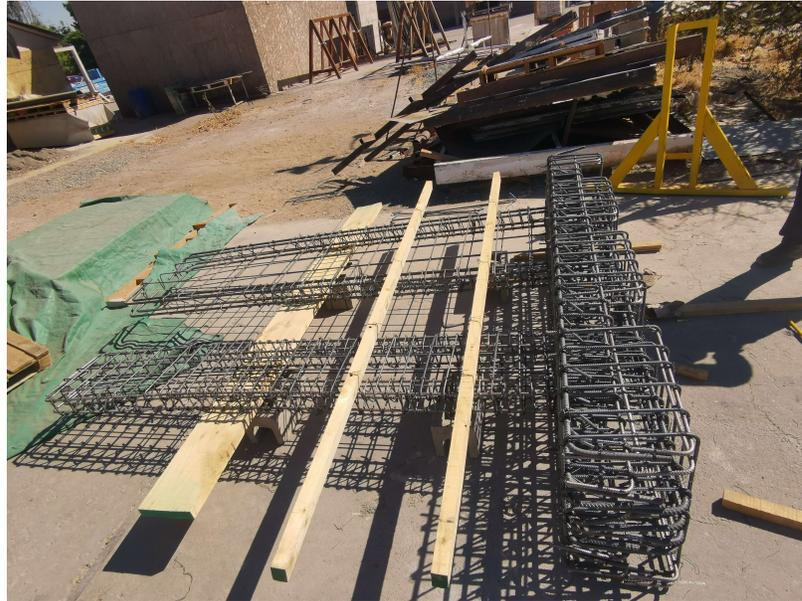
Figura 4.2: Enfierradura probeta
