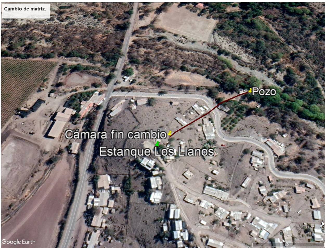
Ilustración 17: Ubicación tubería que requiere ser cambiada. Fuente: Elaboración propia.
