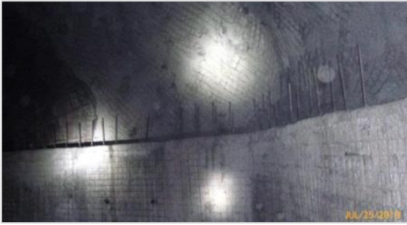
Figura 19: Construcción de refuerzo en puntos de vaciado de C23 RN.
