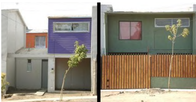
Casas Chubi Fuente: www.plataformaurbana.cl . 12 de agosto de 2008
