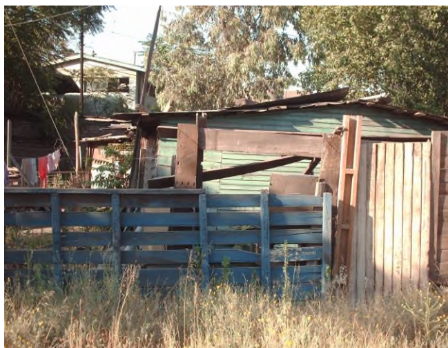
Una de las viviendas de Maestranza San Eugenio. Fuente propia. 10 de mayo de 2008.
