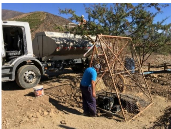
Imagen 4: carga de agua a camión aljibe, pozo y camión municipal.
