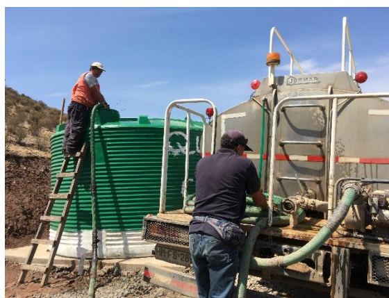
Imagen 2: descarga de agua, estanque de Quebrada de Castro.
