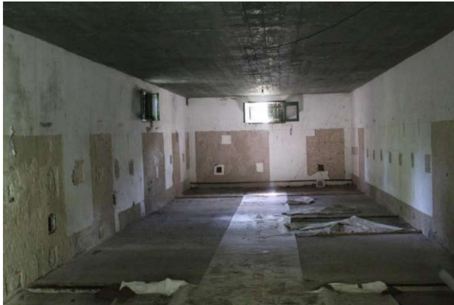
Figura 60 Vista del interior del Galpón 9 (2021).
