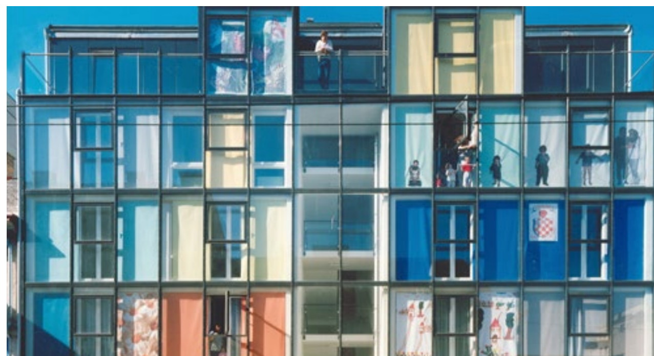
Figura 25. Proyecto Housing Grieshofgasse
