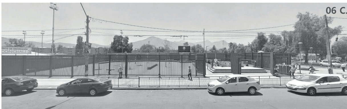
Acceso Estación Cardenal Caro L3
