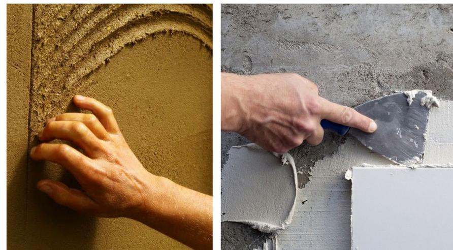
**Imagen 4.87/8** : Revoque Mortero de Cal/Revoque texturizado en tierra.
