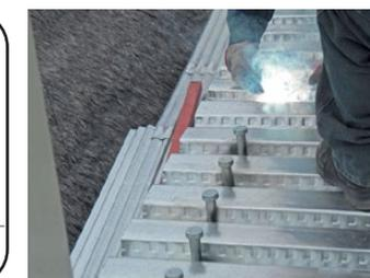
**Imagen 4.100/1 :** Detalle Placa Colaborante / Conector de Corte Fuente: cintac.cl / acero-deck.com
