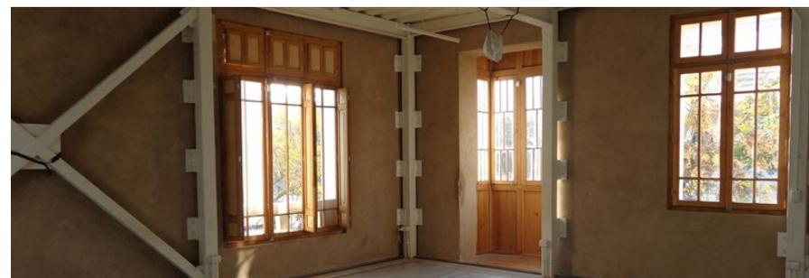
Estas cintas de HA se disponen cada 3m verticales, tras las vigas de acero soportantes, conectando en puntos de unión específicos a las columnas de acero soportantes, las que se propone arriostrar, proporcionando caminos de descarga para transferir cargas horizontales al nivel de suelo, y proporcionar estabilidad lateral.
