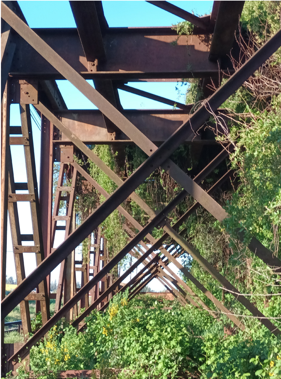
Vigas reticuladas en su estado actual.
