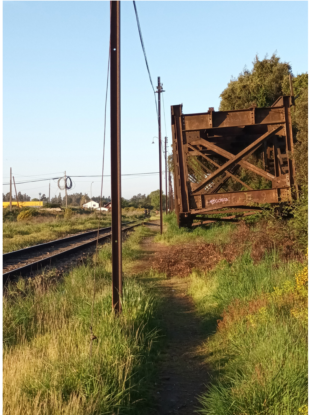
Vigas reticuladas en su estado actual. ..... Fotografía tomada por el autor.
