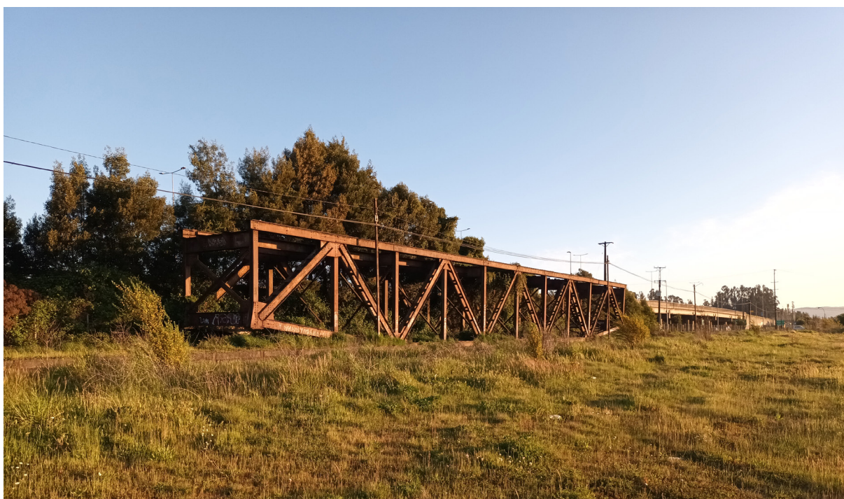
Vigas reticuladas en su estado actual.
