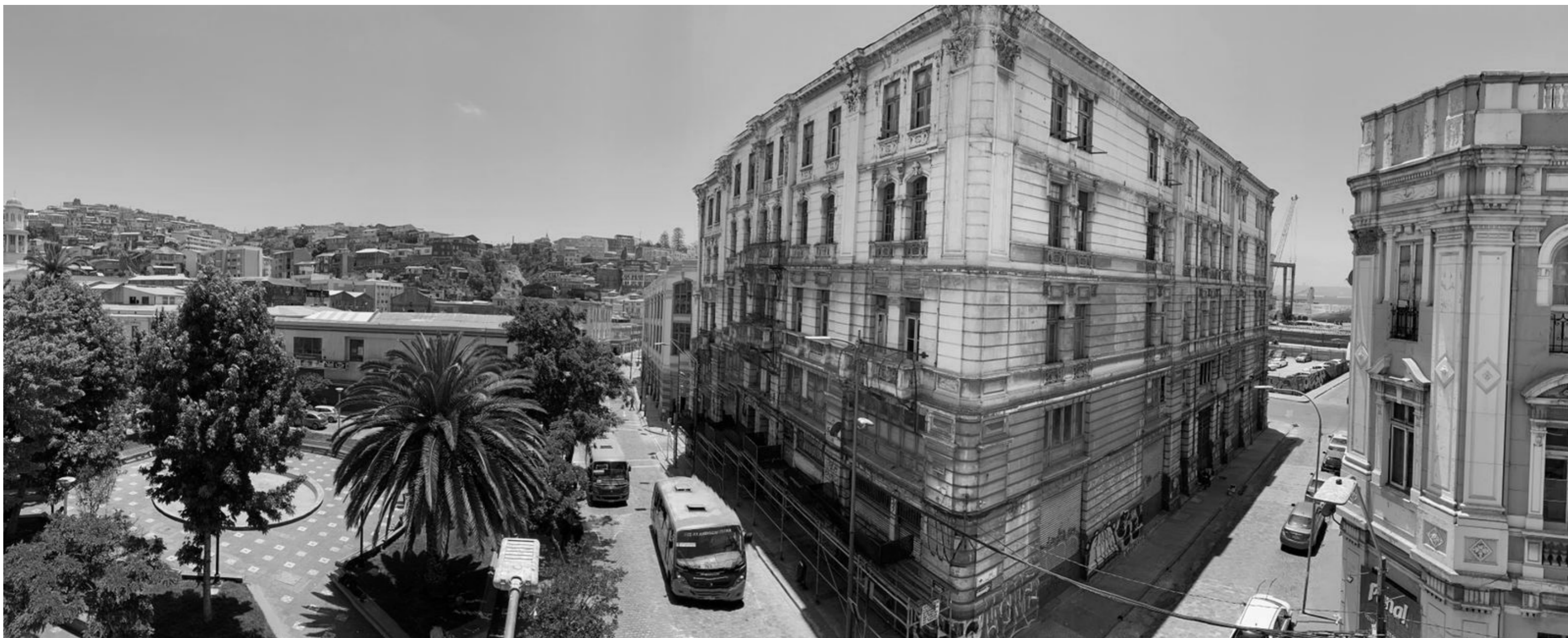
Fig 8. Edificio Astoreca y proximidades. Elaboración propia.
