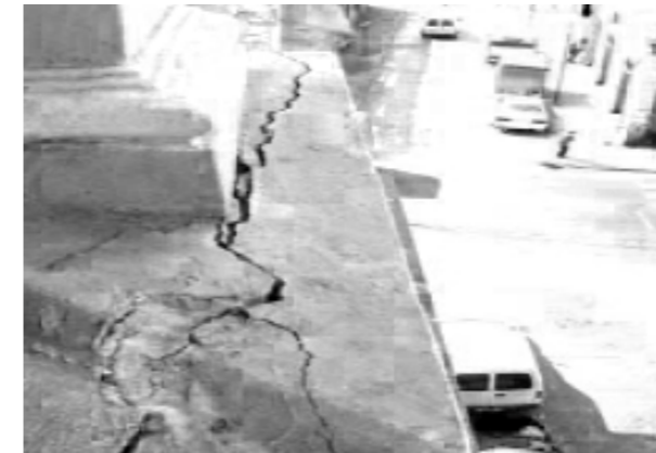
Fig 21. Imagen extraída de ficha estructural del inmueble (2011)
