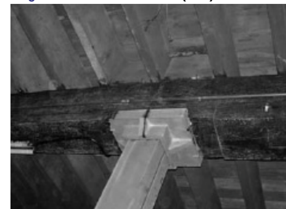
Fig 25. Imagen extraída de ficha estructural del inmueble (2011)
