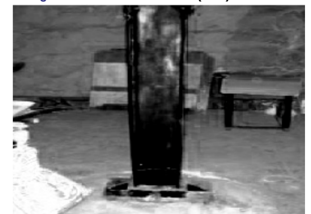
Fig 26. Imagen extraída de ficha estructural del inmueble (2011)
