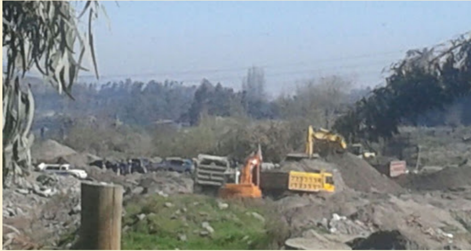
Extracción de áridos de la cuenca del Río Clarillo, altura Puente Blanco. Fuente: Portal Pirque, 18 Agosto 2017.
